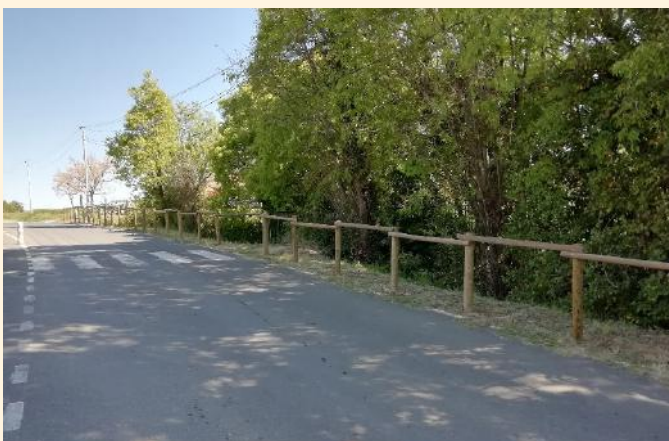
Réfection de la barrière Chemin du Bois
