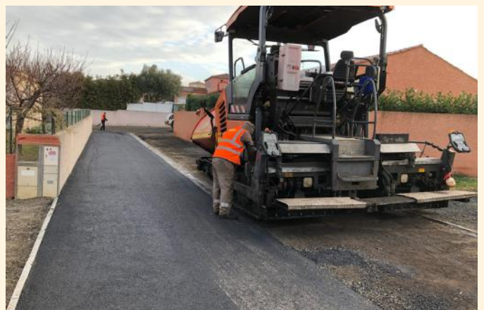
Réalisation de l'enrobé «impasse du Muscat»
