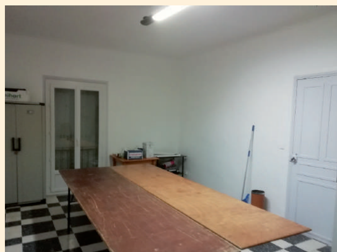
Réfection du local des Anciens Combattants
