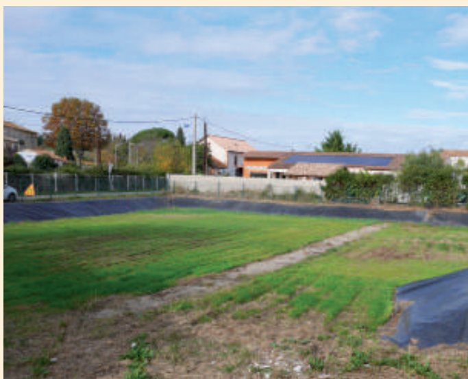
Bassin de rétention de la Colline Fleurie
