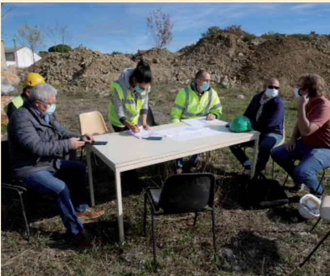
Réunion de chantier à la STEP
