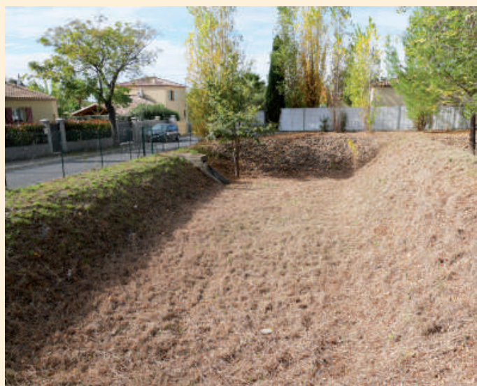
Bassin de rétention du Lotissement le Pradinels
