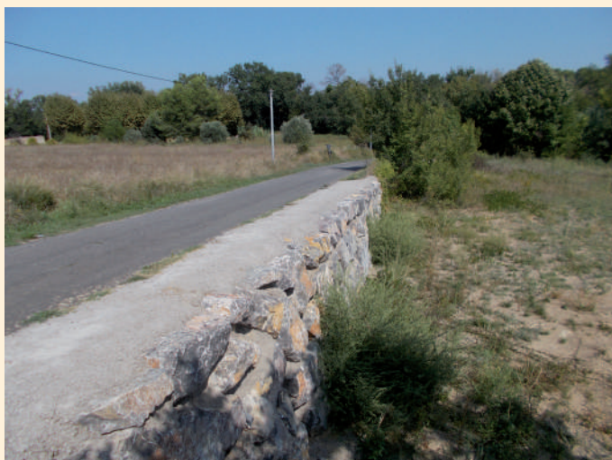
Remise en état de la traverse Magalas-Laurens
