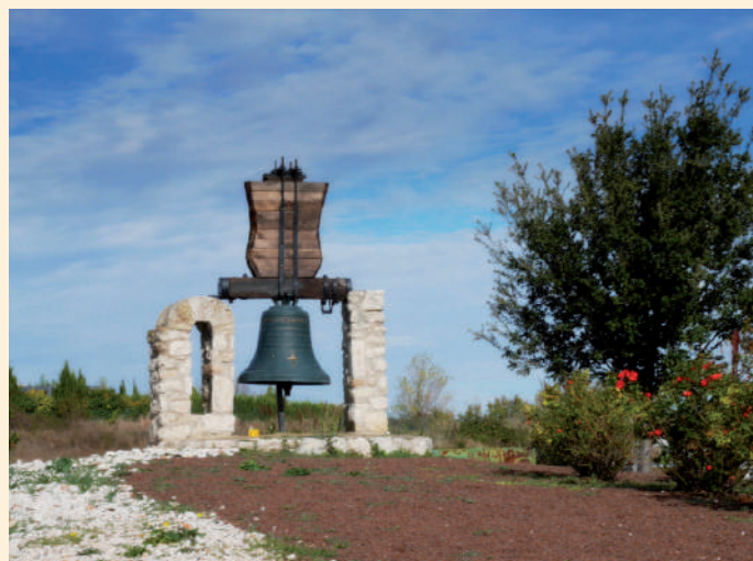
Réfection du joug de la cloche au giratoire de la ZAE
