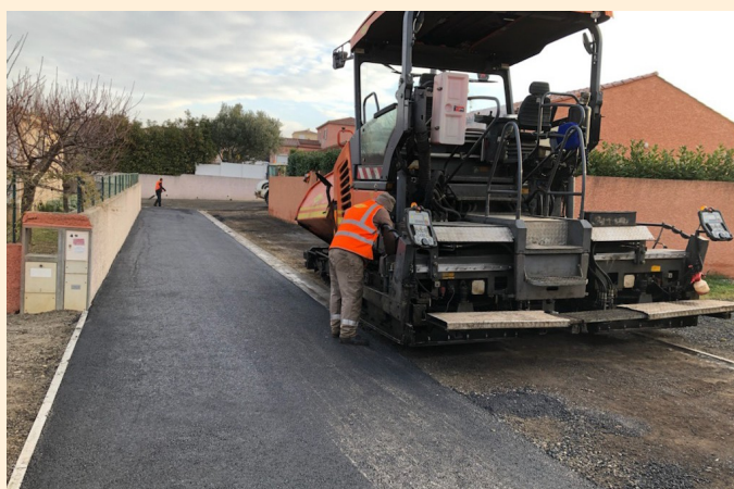
Laying of asphalt on the «impasse du Muscat»
